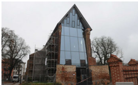
Neue Glasfassade der Kirche St. Johannis
