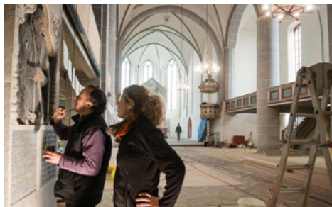
Restaurierungsarbeiten in der Kirche St. Laurentius
